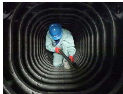
写真－５ 槽内土砂除去作業
