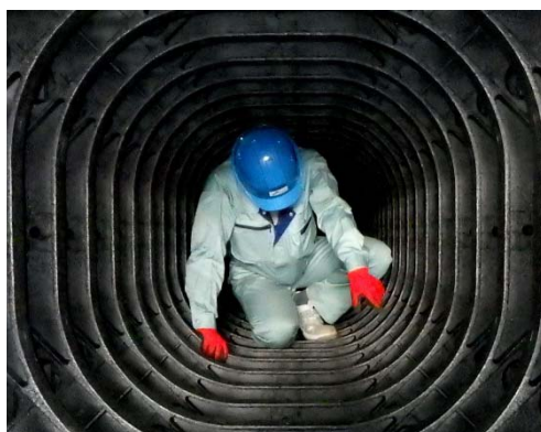
写真-1 槽内点検作業状況
