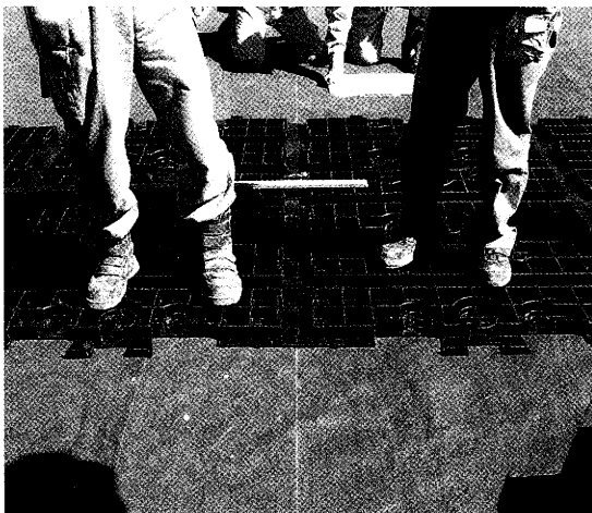
写真4 基準線に合わせて敷き始める
