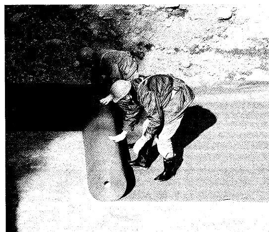
写真2 定尺シート敷設
