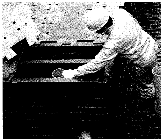
写真9 鏡板の内側に塩ビ管を設置
