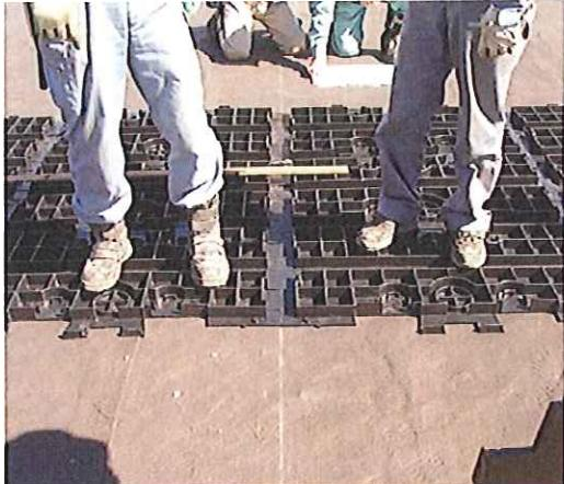
写真4 基準線に合わせ敷き始める
