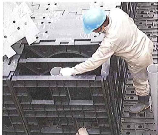
写真9 鏡板の内側に塩ビ管を設置
