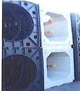
写真8 点検口2段敷設例
