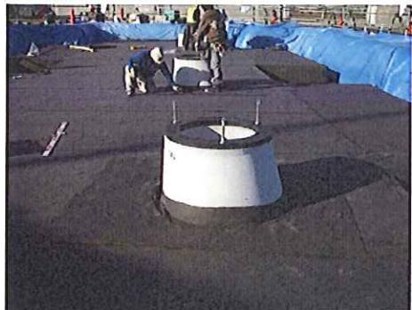
写真12 キャップボルト調整パッキン設置状況
