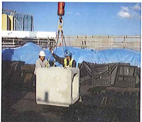
写真2 点検口設置状況
