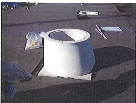
写真11 斜壁設置状況
